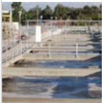
■ 污水处理系统
